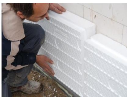
Przyklejanie płyty ArtBrick metodą mijankową Fot. ArtBrick
