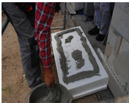
Nanoszenie zaprawy klejowej ArtBrick KS
