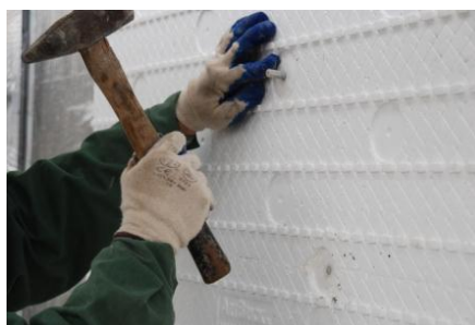
Kołkowanie umacnia całą elewację. Fot. ArtBrick
